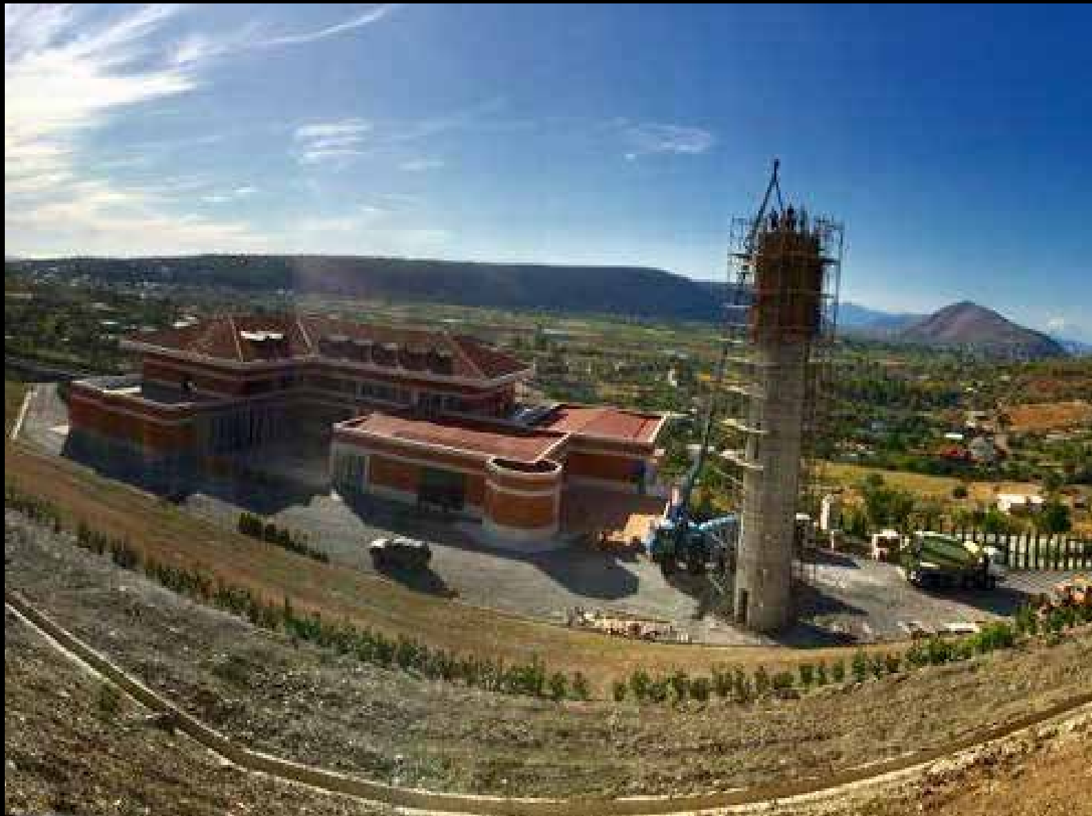
Panoramica del Seminario settembre 2017 con la costruzione del campanile in opera
